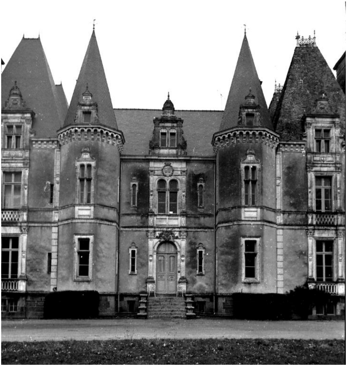
Façade sud, travée centrale.
