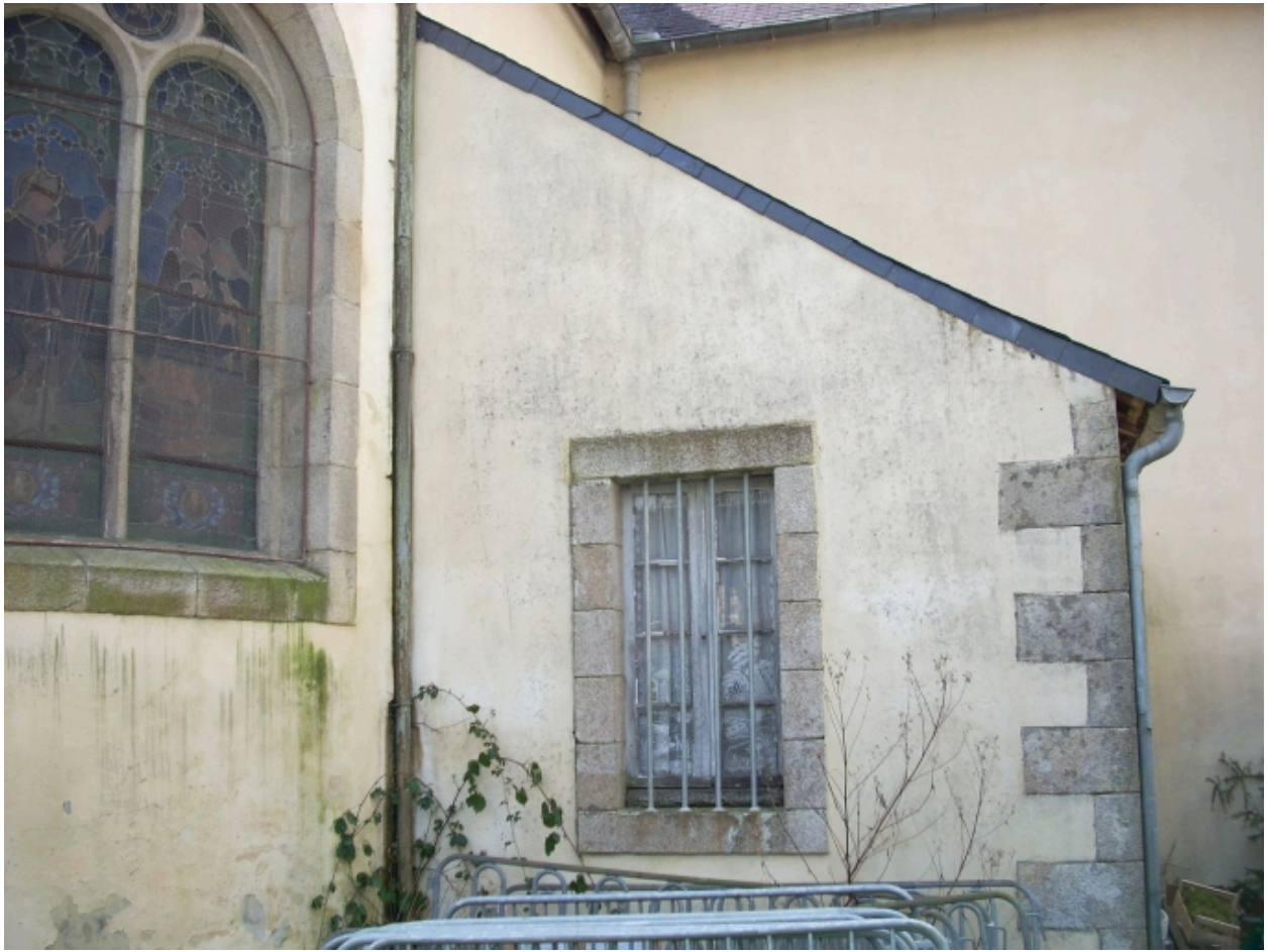
Port-Launay, église paroissiale Saint-Nicolas : sacristie nord
