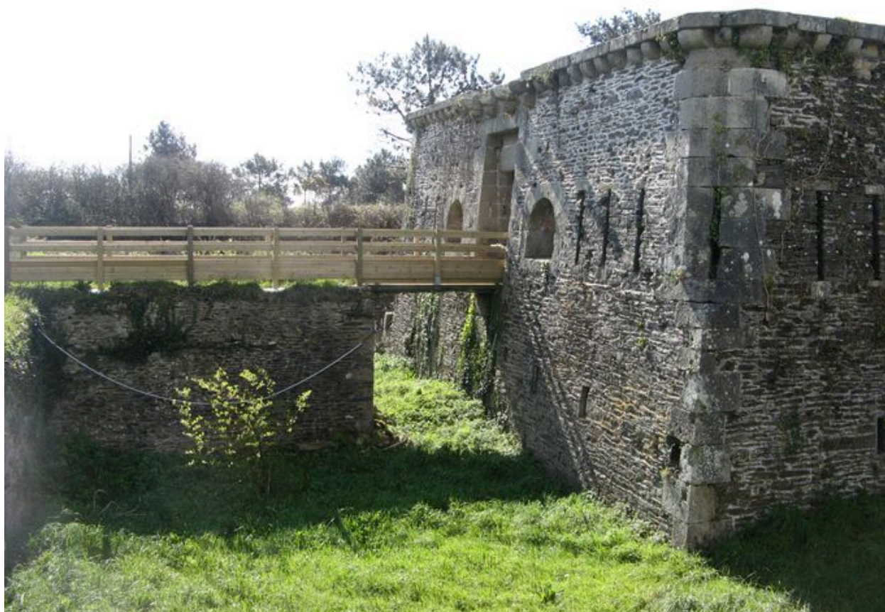
Tour-réduit de la pointe des Espagnols
