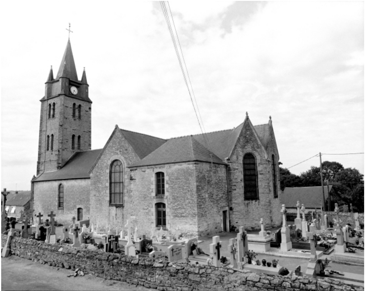
Elévation sud, vue générale.
