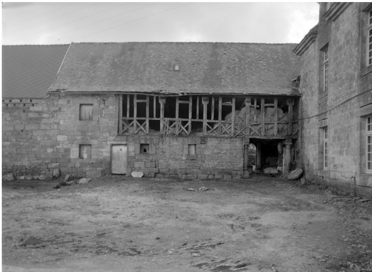
Aile gauche : détail de la partie en pan de bois
