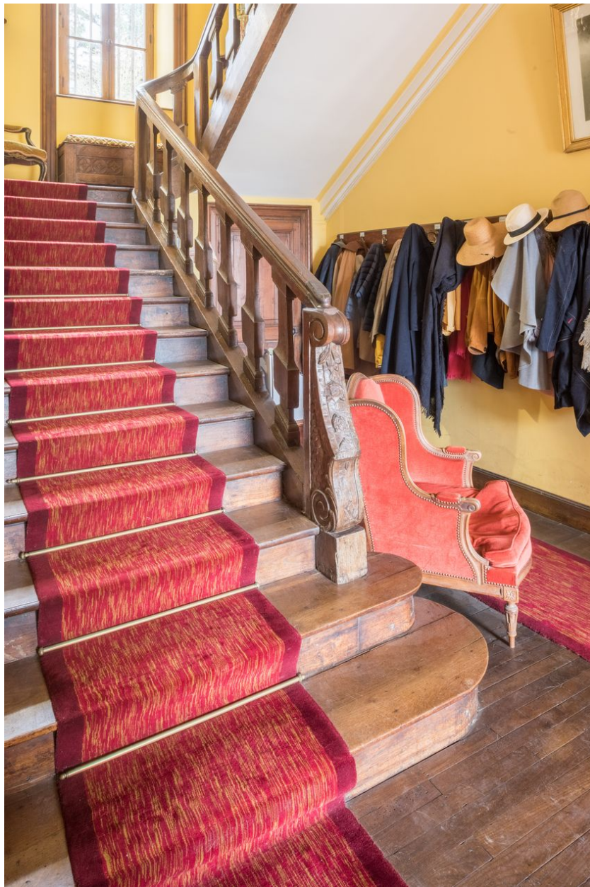
Vue intérieure, départ de l'escalier à balustres de section carrée
