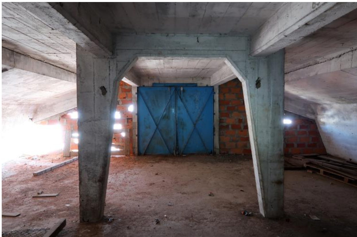
Troisième étage (quatrième niveau) : extrémité nord
