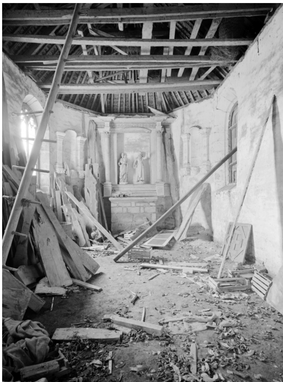
Chapelle, vue générale de l'intérieur d'ouest en est, état en 1967
