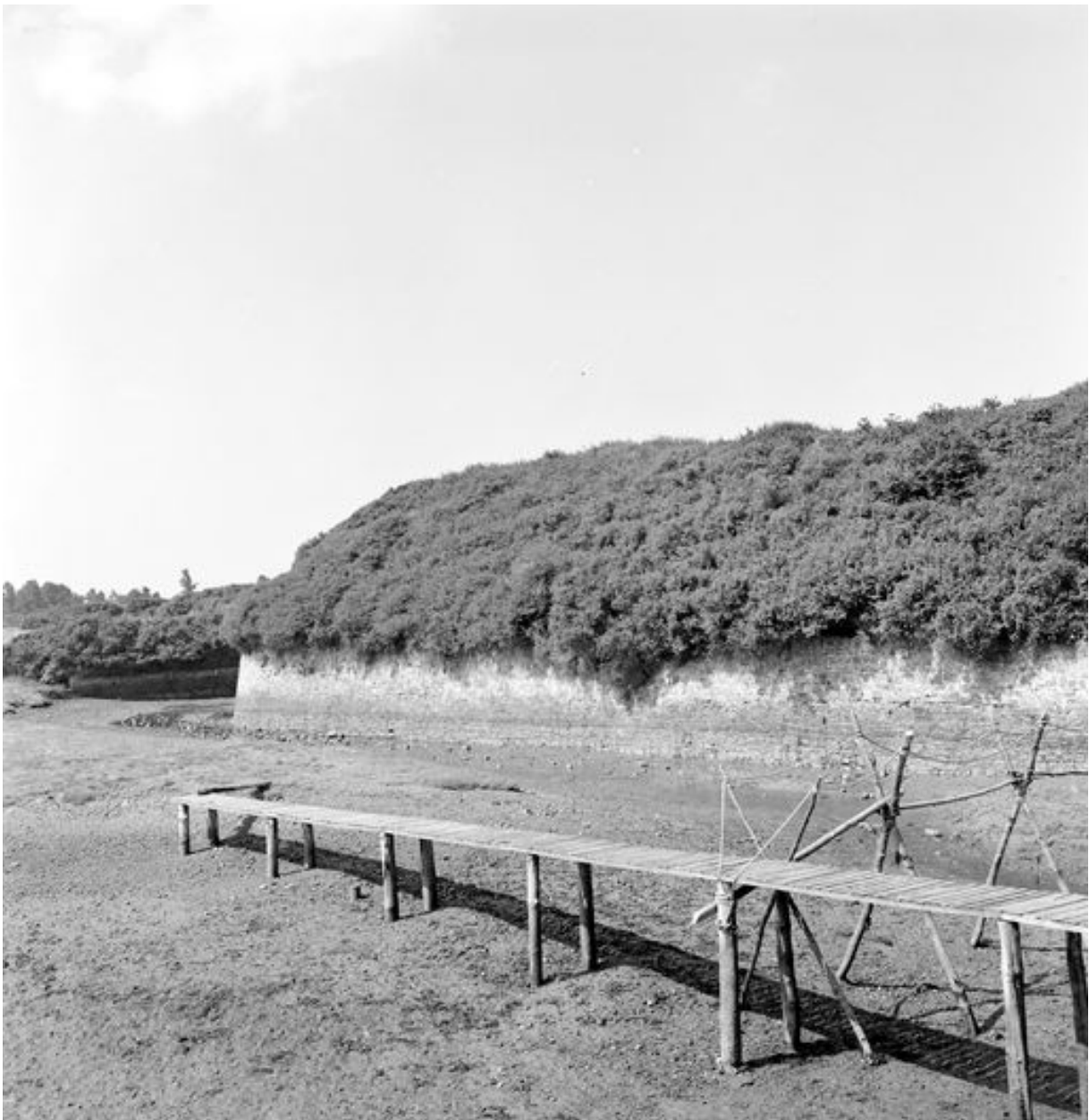
Vue des lignes de Quéléren en 1969 : escarpe de l'orillon 8 au niveau du bassin de retenue des eau
