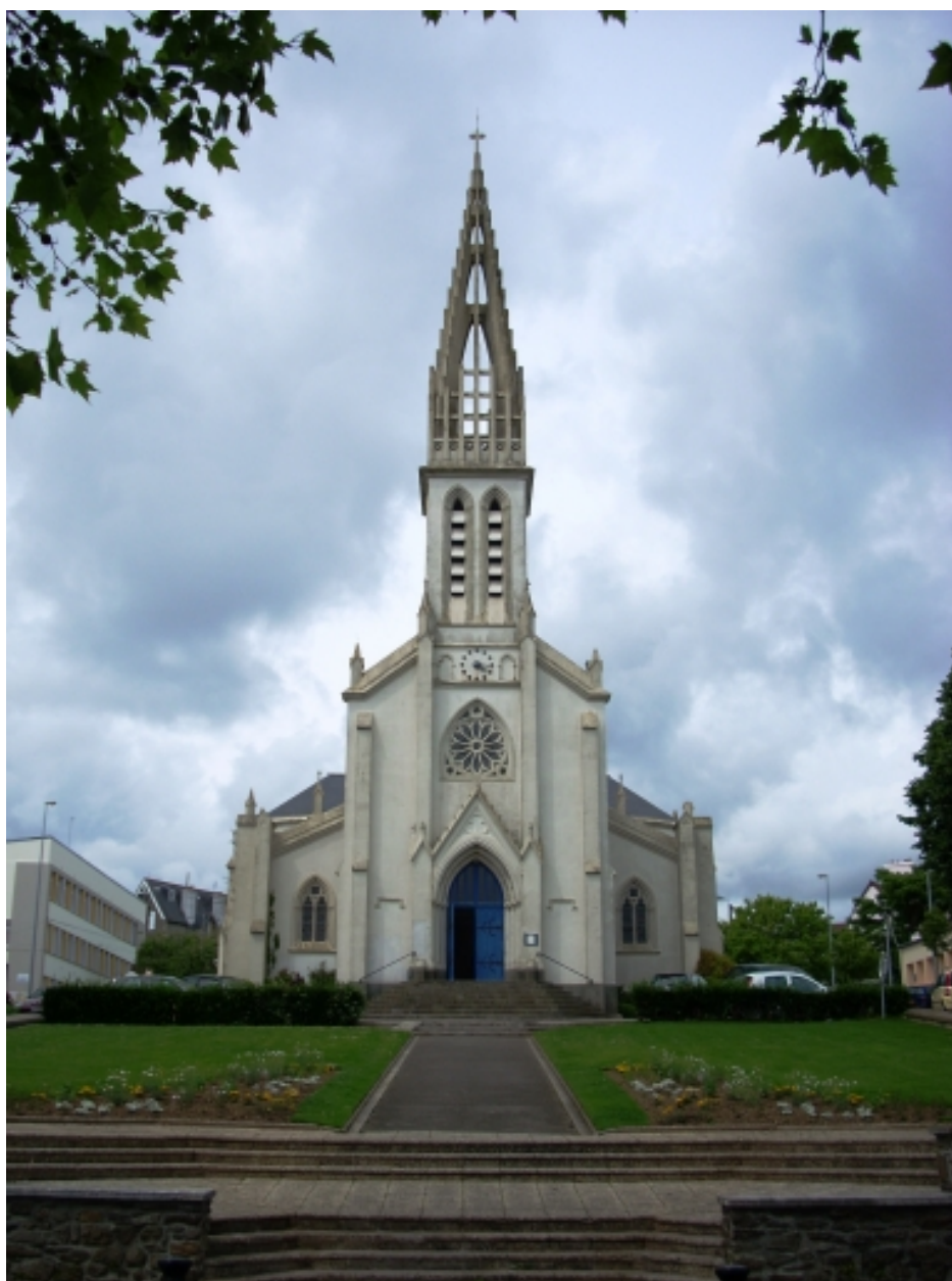
Brest, église Saint-Marc : élévation ouest
