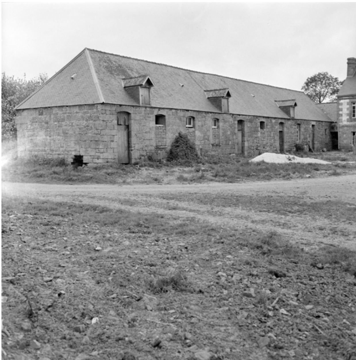
Communs : vue générale (état en 1974).
