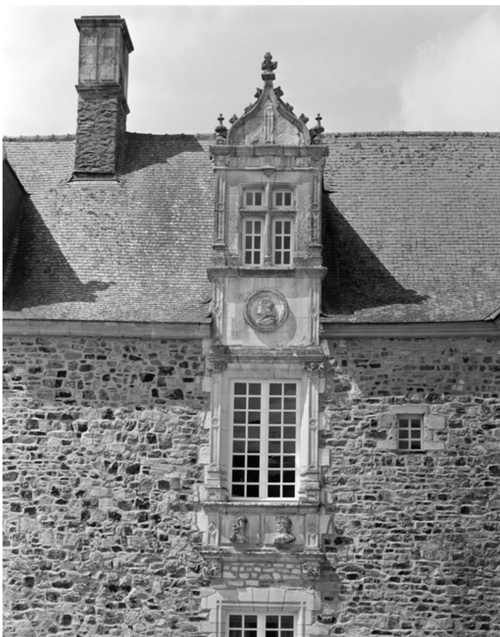
Elévation principale : détail de la lucarne centrale.
