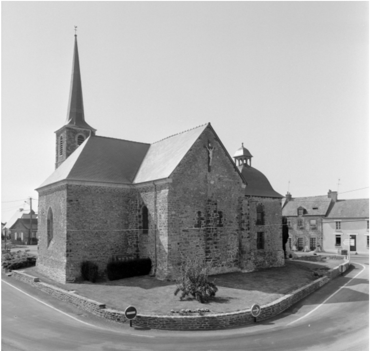
Elévation Est : vue générale
