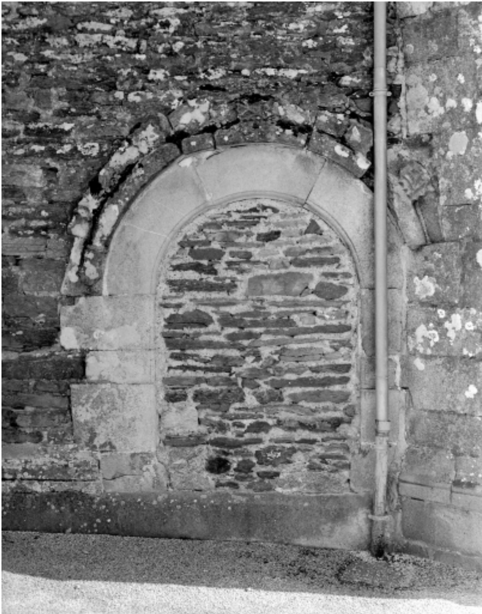
Elévation Sud, bras du transept, porte ouest : vue générale
