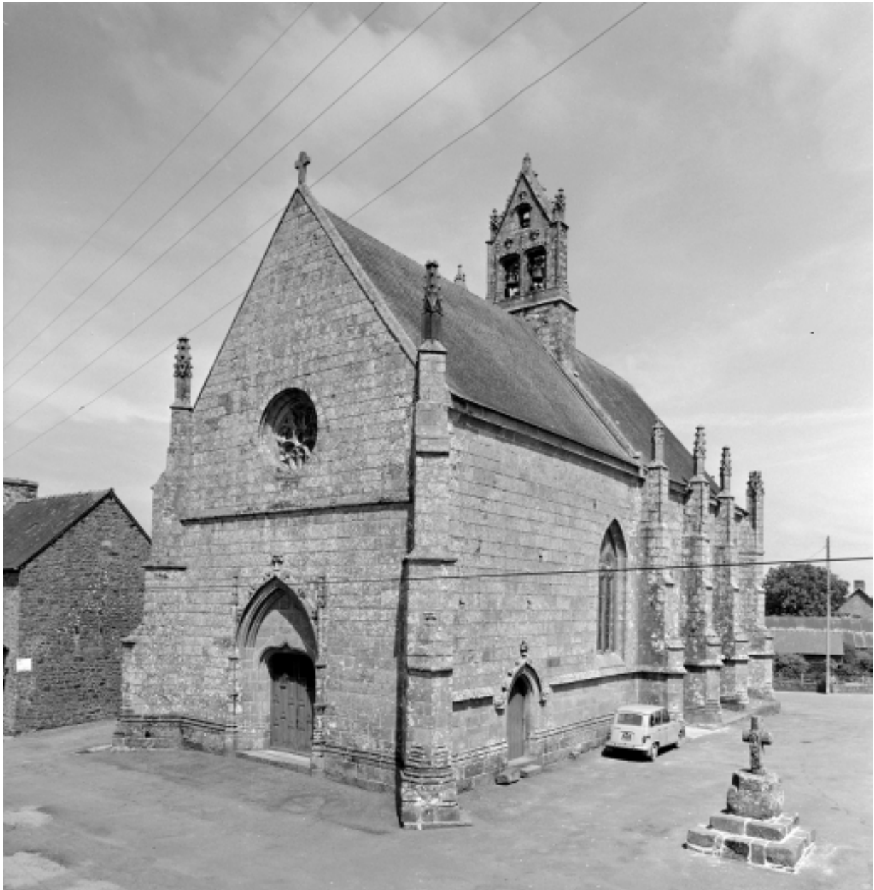
Elévation Ouest : vue générale
