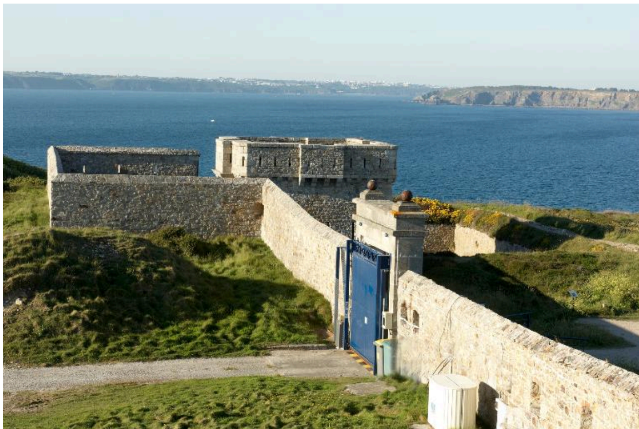
Camaret-sur-Mer, pointe du Toulinguet : vue du mur défensif percé de créneaux de fusillade
