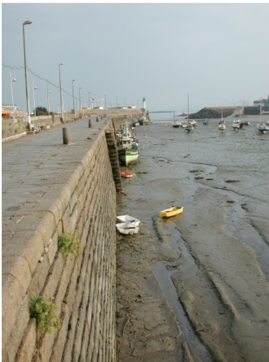
Vue du fruit du mur du quai de la jetée
