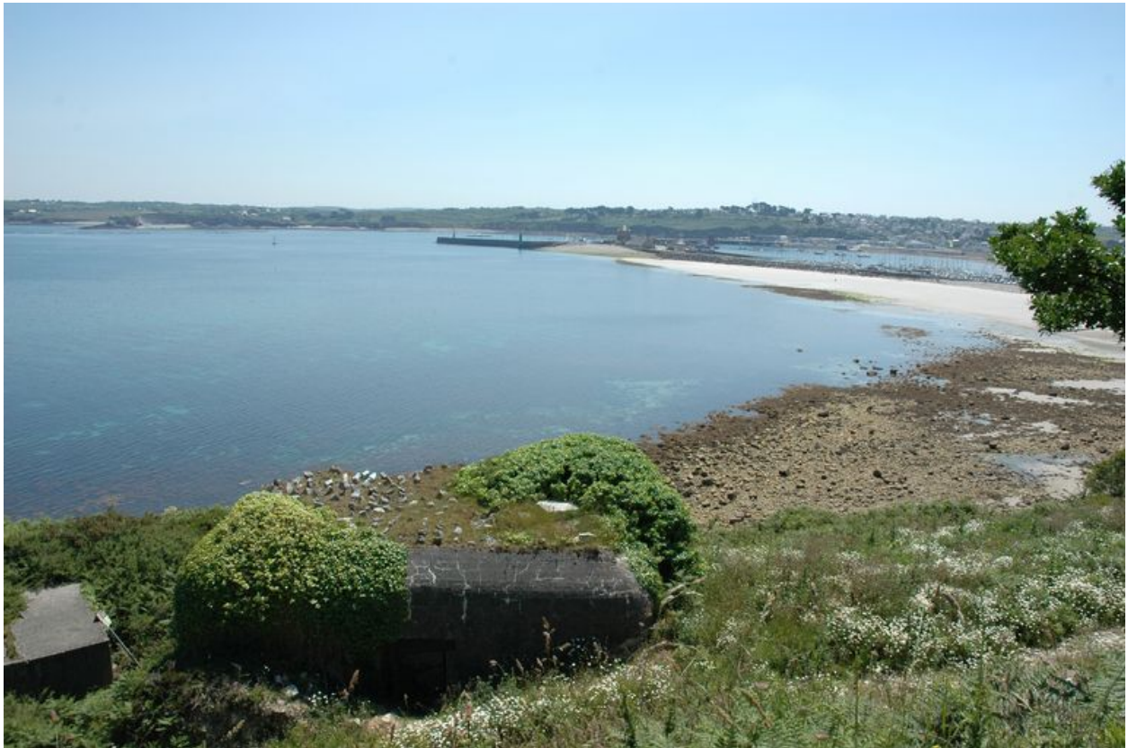
Vue de la dalle de couverture du bunker - casemate de type 671 sud (état en 2005)
