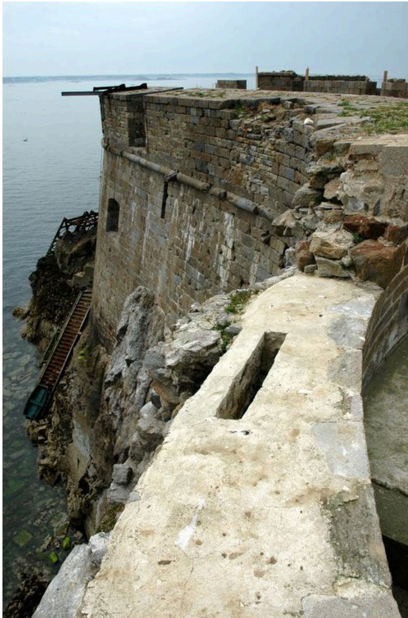
Vue du fort de la Conchée : parapet de la plate-forme d'artillerie (batterie haute). Au premier plan : événement d'aération d'une des casemates
