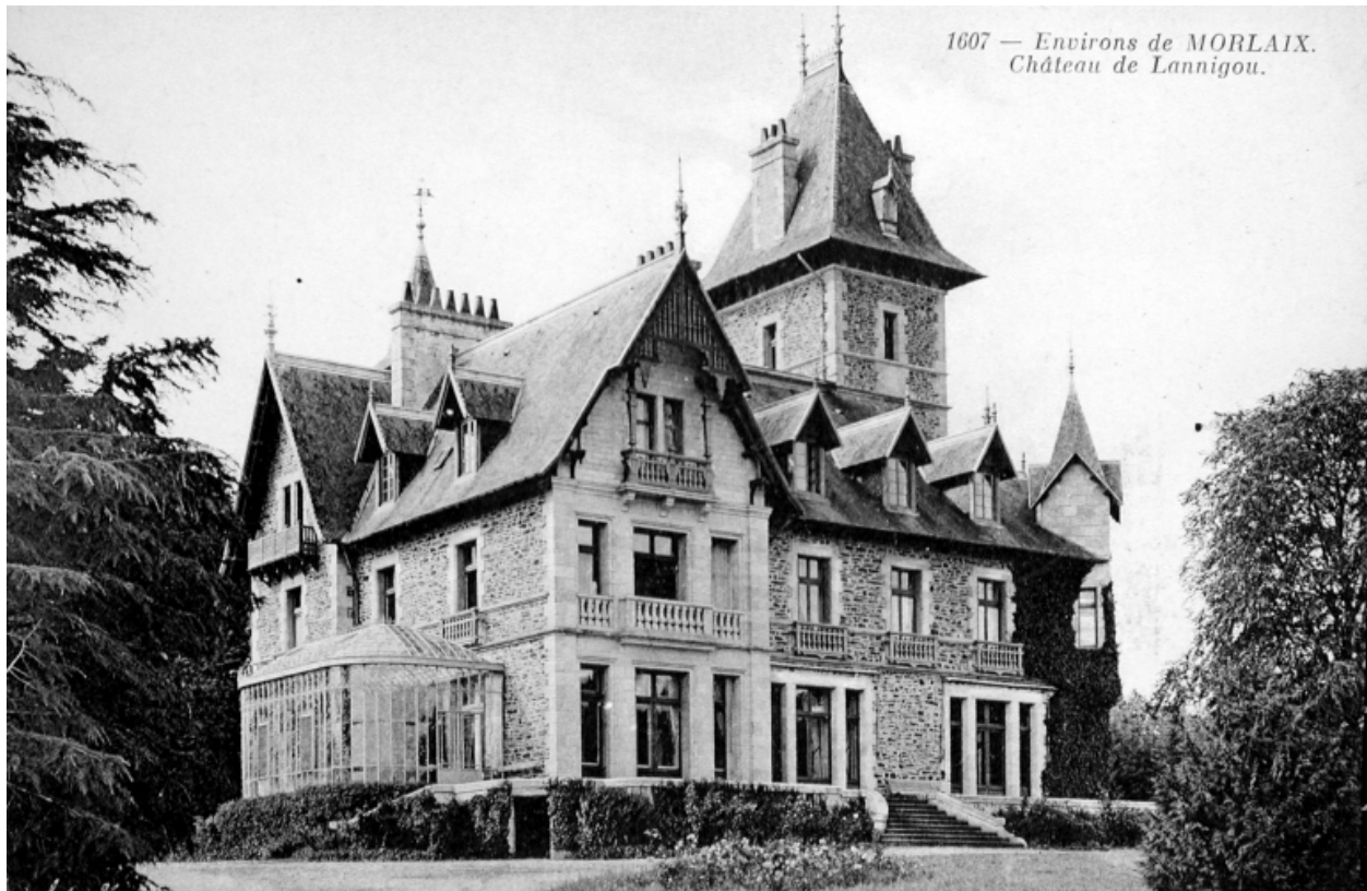
Vue générale de la façade postérieure
