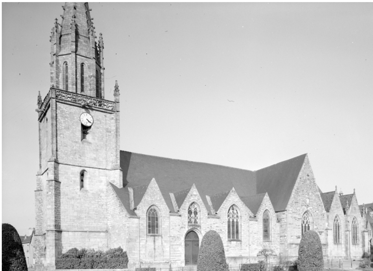
Vue d'ensemble de la façade sud.
