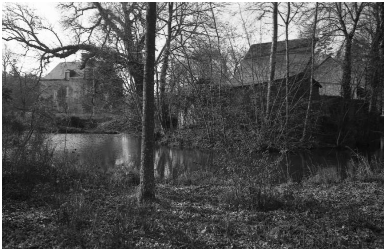
Vue de situation du nord-est.
