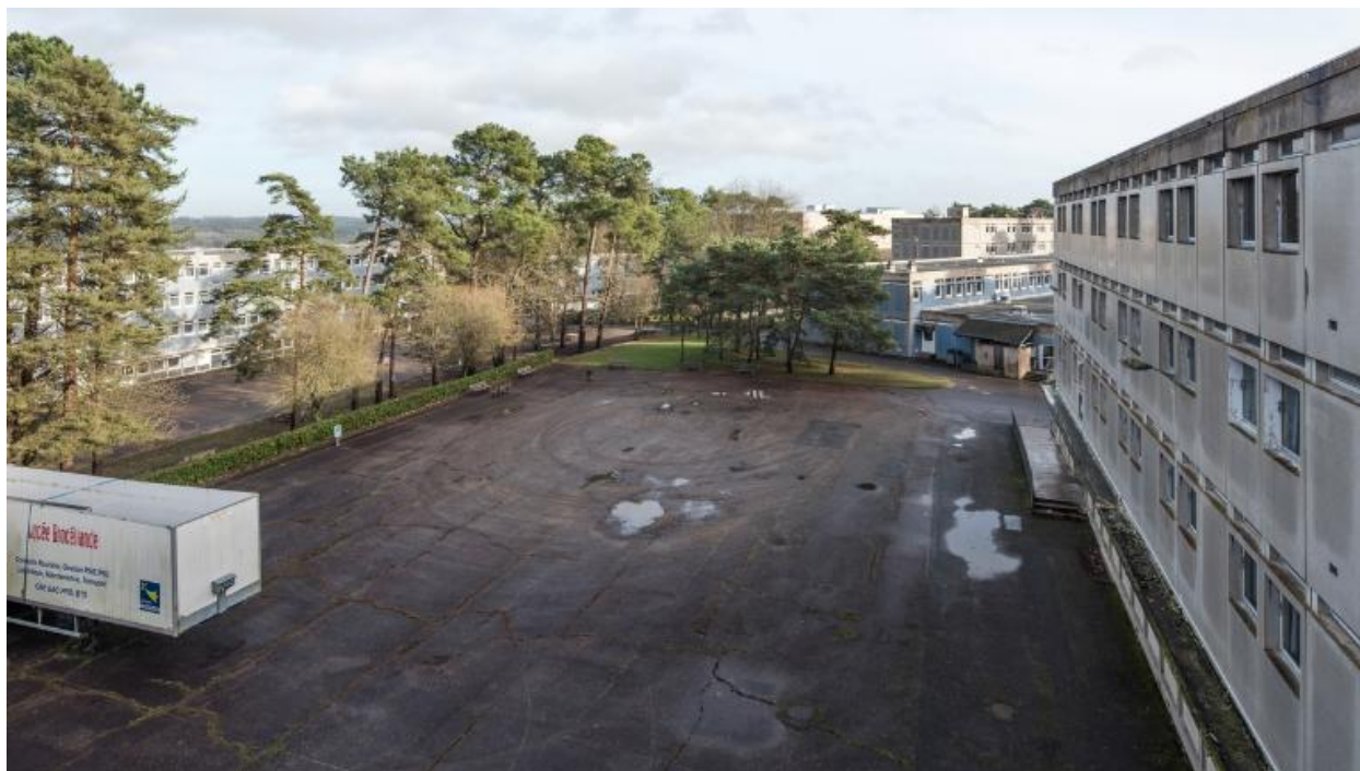
Vue d'ensemble prise des toits du bâtiment B.
