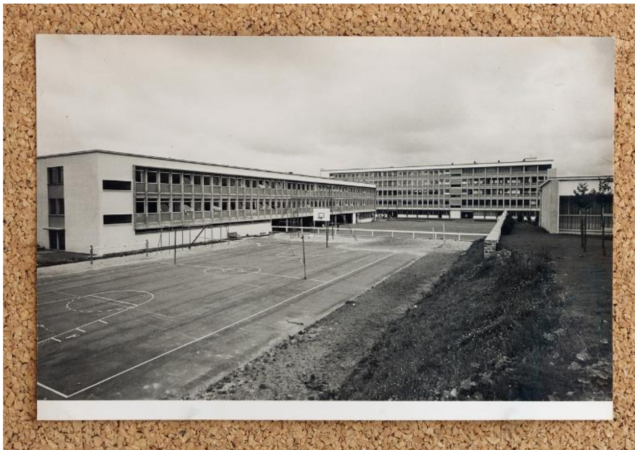
Bâtiments B et C.
