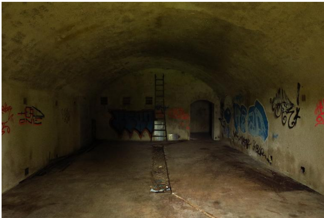
Le Palais, enceinte urbaine, réduit C, première travée de droite.
