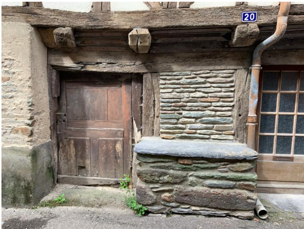
Maison à gauche. Rez-de-chaussée
