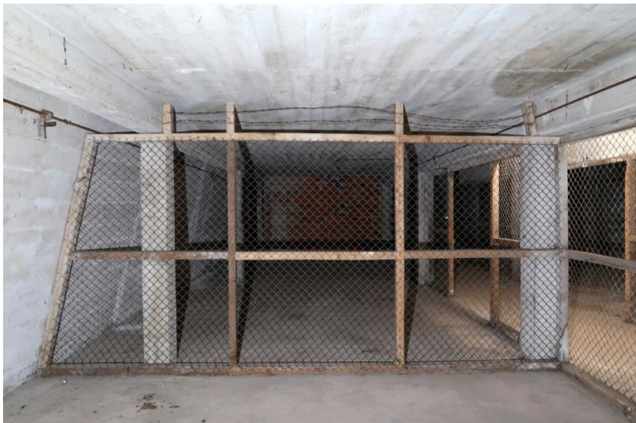
Deuxième étage : grillage surmonté de deux rangs de fil barbelé séparant deux boxes
