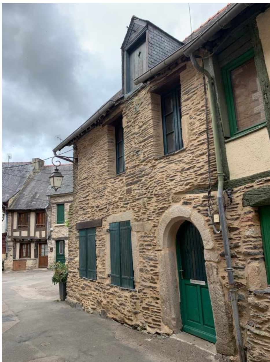
Elévation est, partie sud
