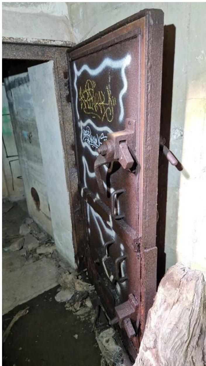
Vue de l'entrée sud : porte blindée à deux vantaux
