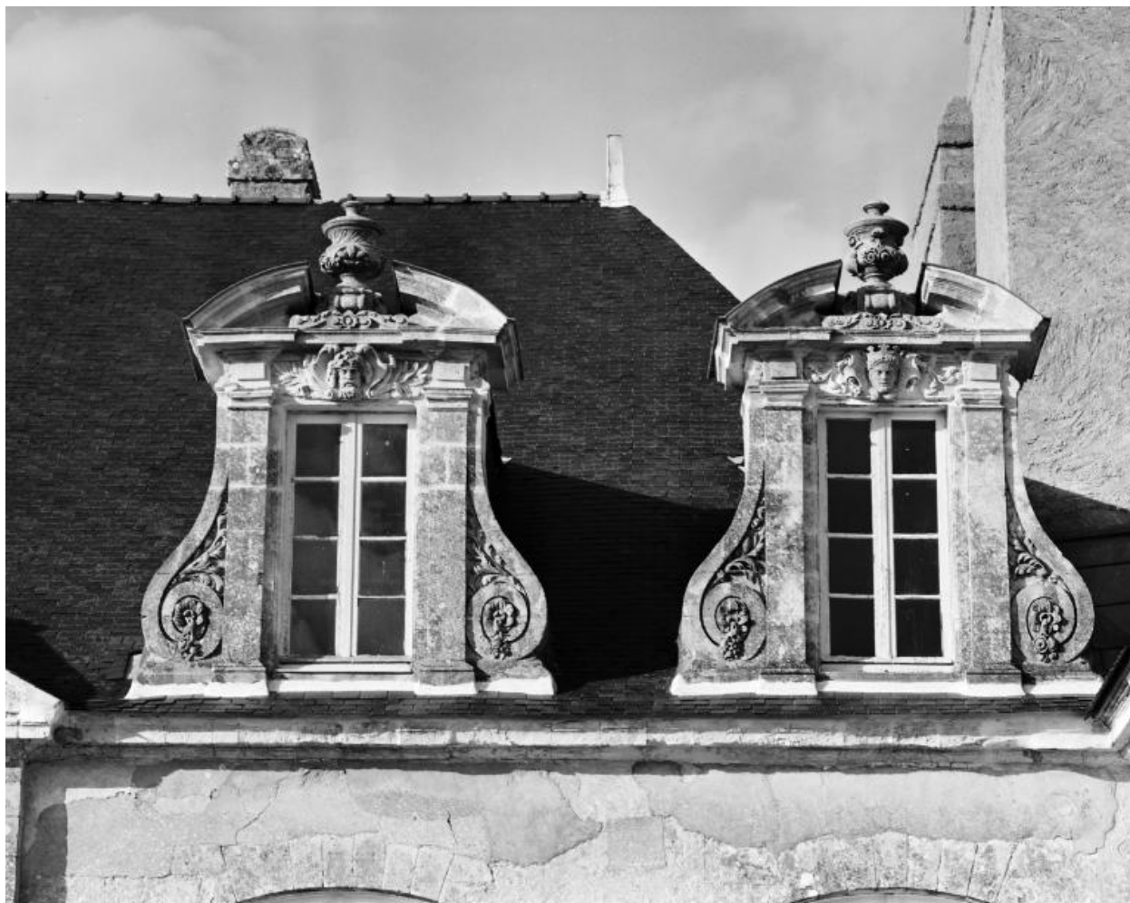
Château, corps principal. Elévation sud, lucarnes.
