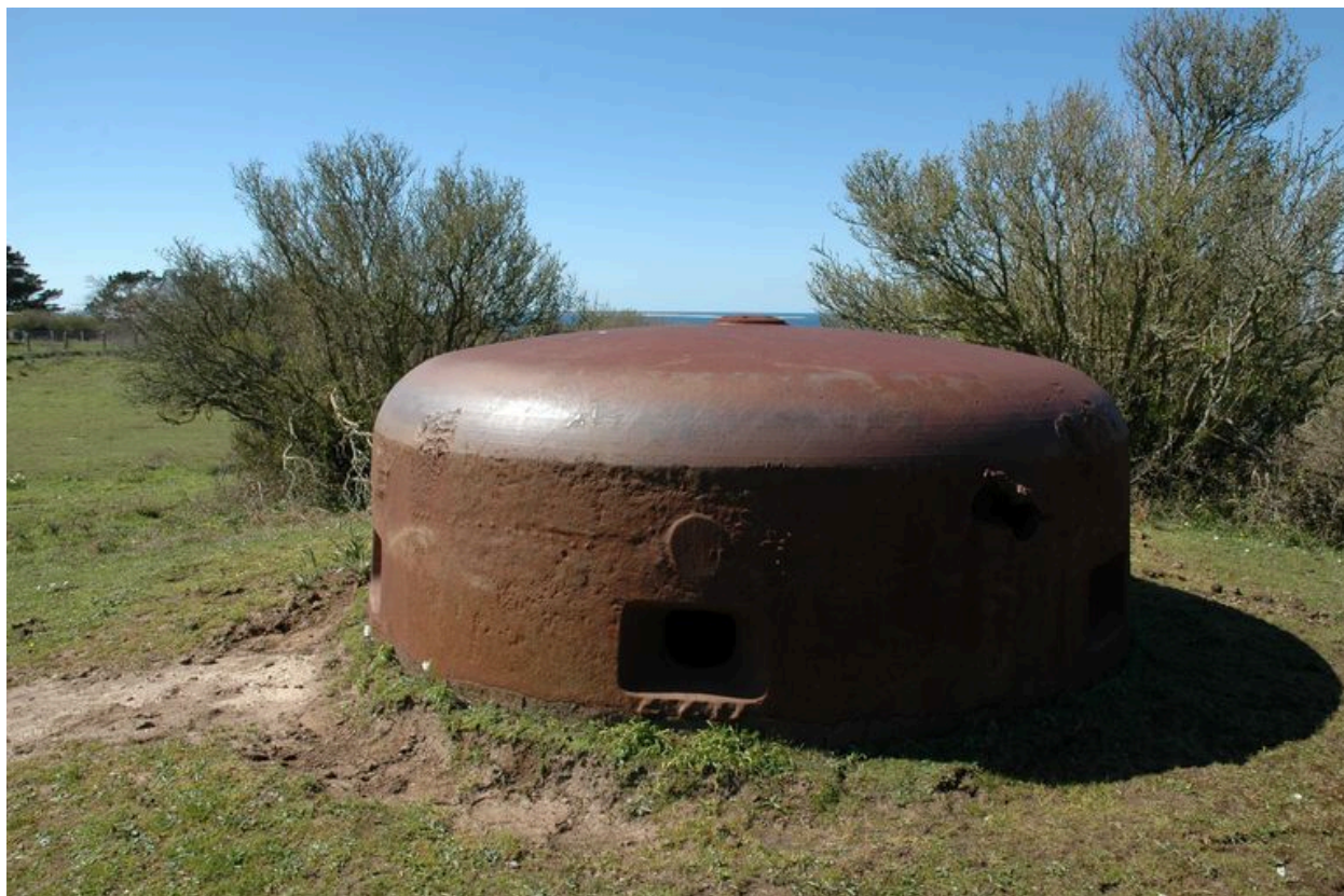
Vue de l'ensemble fortifié de la pointe du Renard : casemate de type 634 avec cloche blindée à 6 embrasures de type 20P7 (propriété privée)
