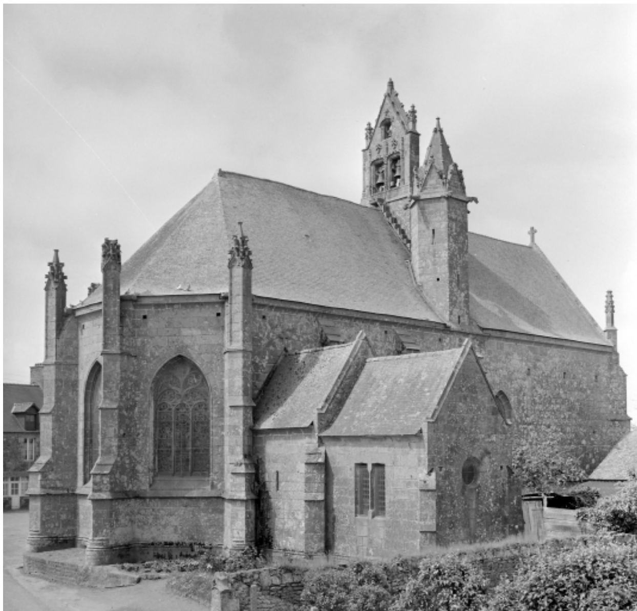
Elévation Nord-Est : vue générale
