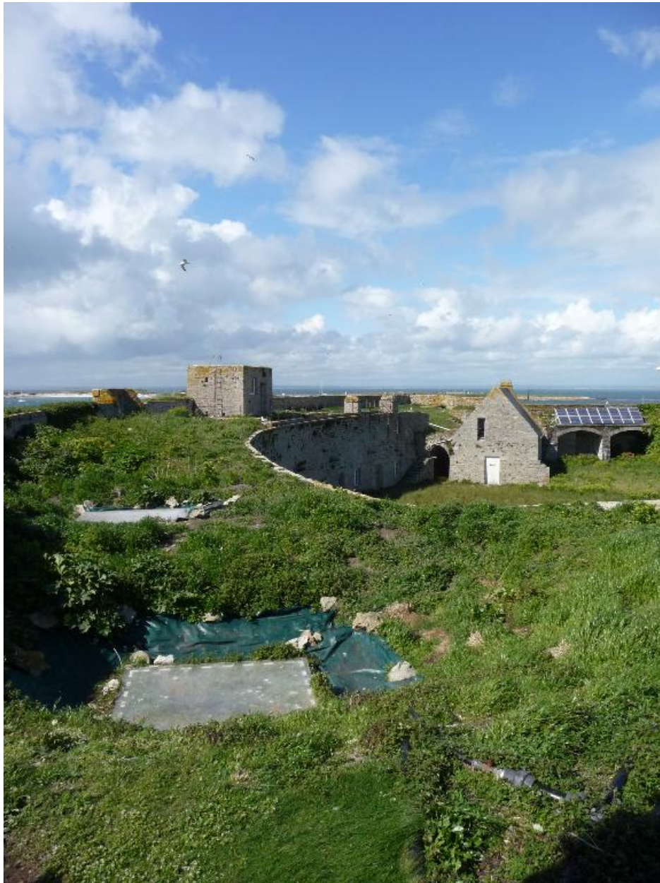
Rempart sud ouest - vue sur les puits de lumière des salles à manger - le quart - la maison des officiers - Cigogne avant ouverture -mai 2014
