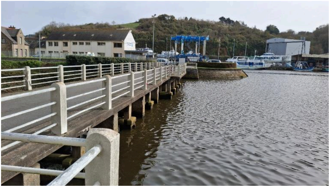
Vue générale du pont déversoir vers l'ancien site départemental
