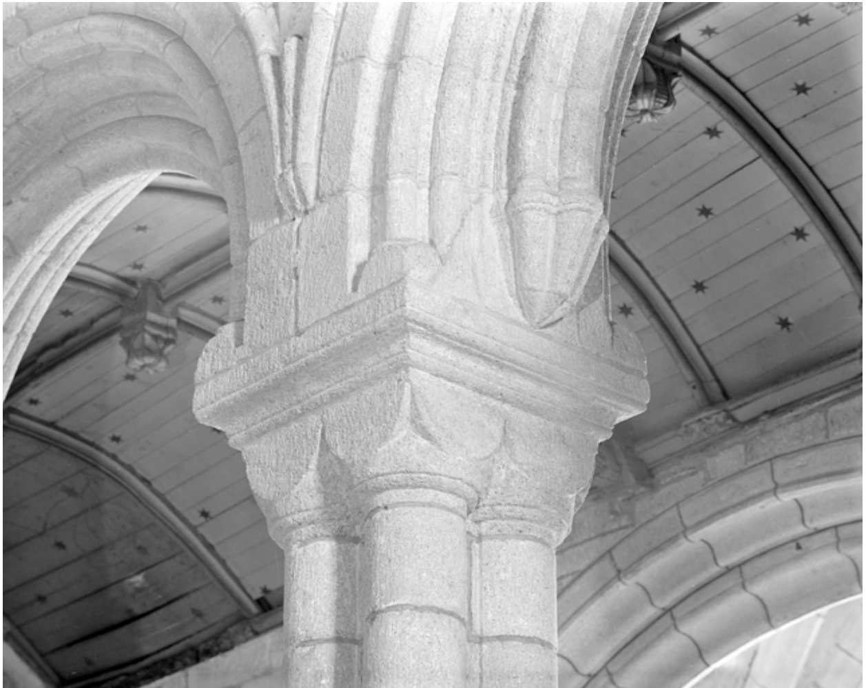
3e pile sud, vue nord-ouest
