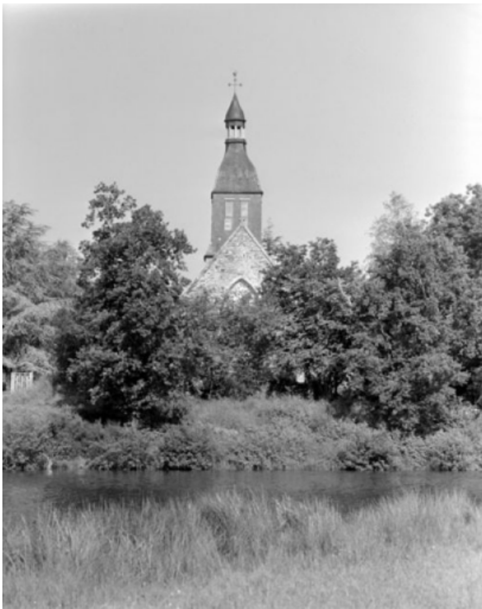
Élévation est, clocher : détail de la tour
