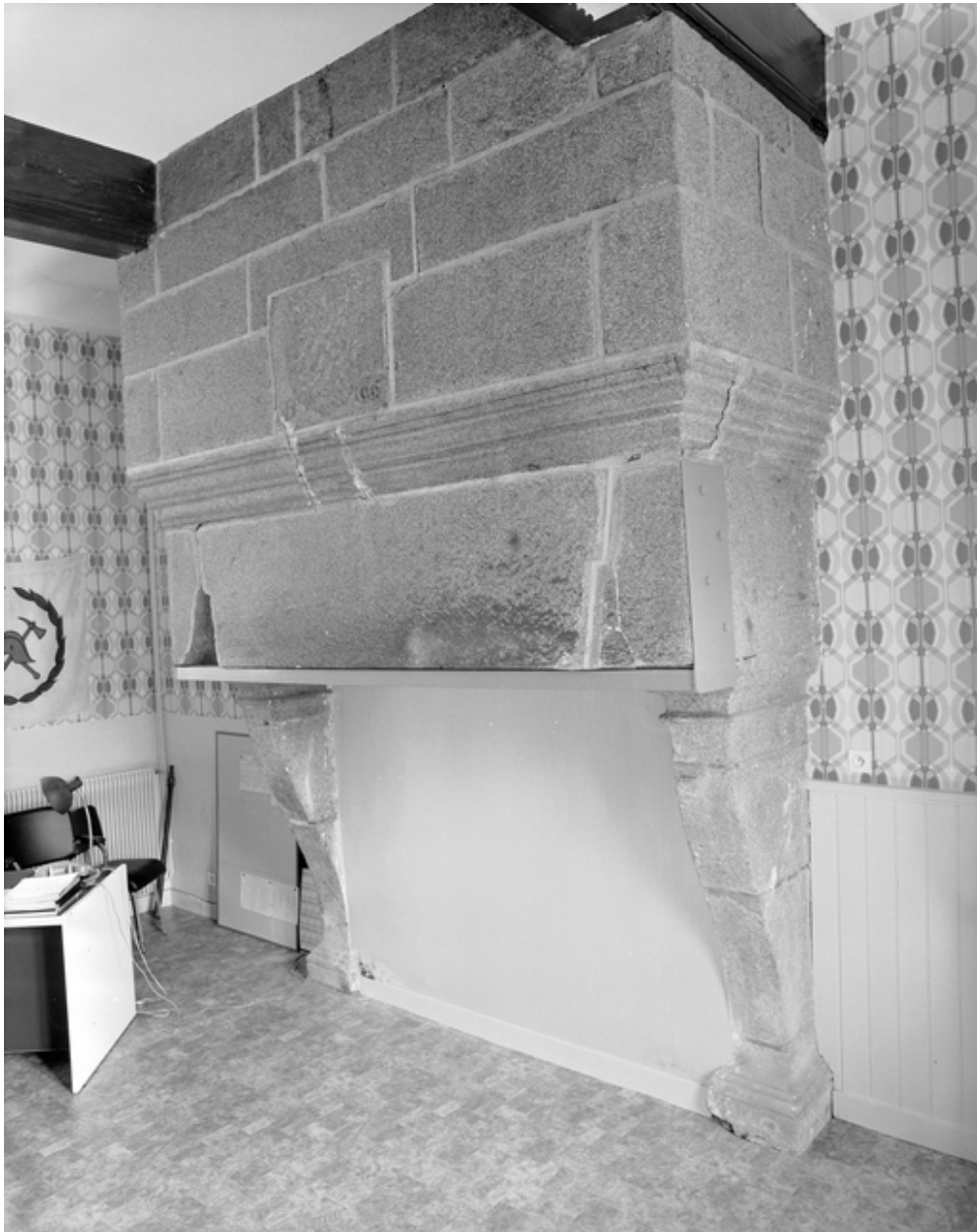
Vue générale de la cheminée du rez-de-chaussée.
