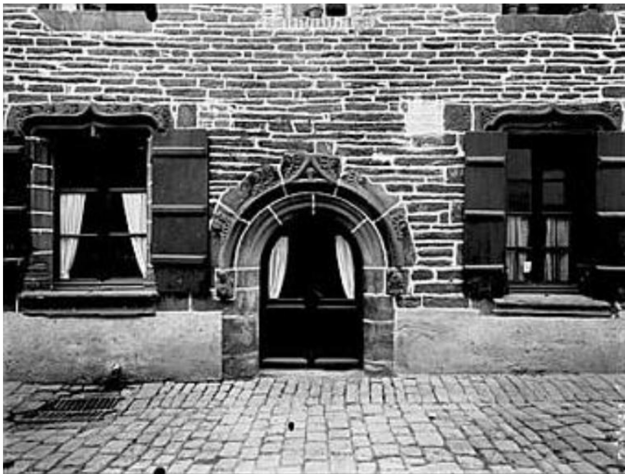
Maison, élévation antérieure, 1er niveau : les baies de la partie centrale (état en 1921)
