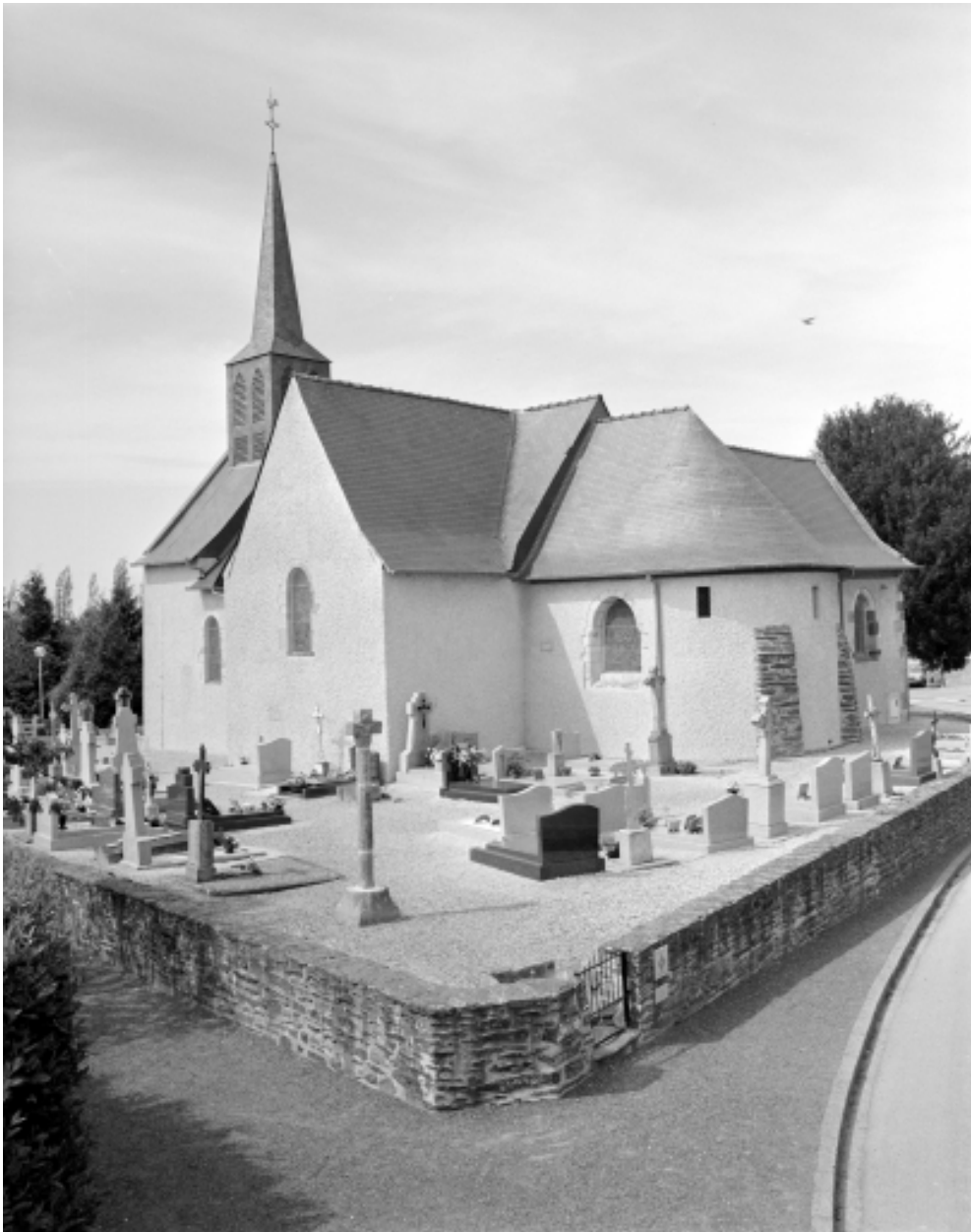
Elévation Sud-Est : vue générale
