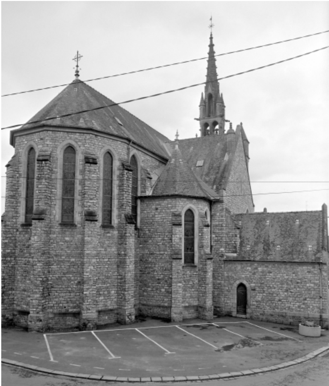
Elévation Nord-Est : vue générale
