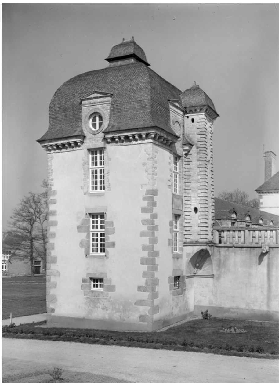
Pavillon gauche : vue générale.
