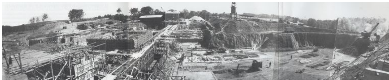
Vue panoramique du chantier de la base V 2, Kraftwerk Nord West (KNW) de la forêt d'Eperlecques
