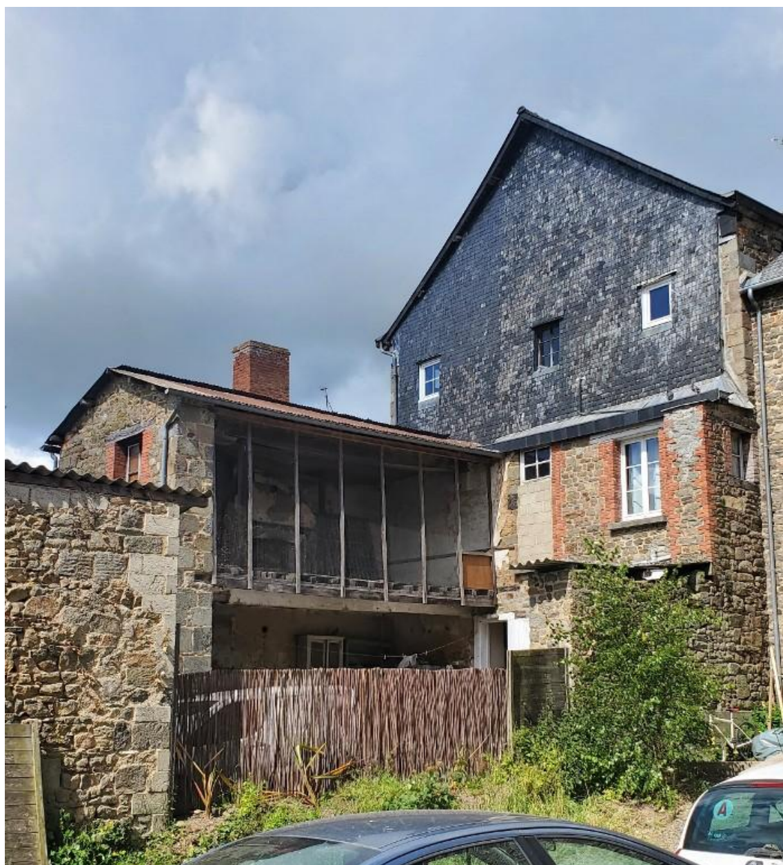
Vue Sud-Est sur le pignon du n°20 rue Châteaubriand, couvert d'un essentage d'ardoise et son extension en retour d'équerre avec la façade ouvert (2024).
