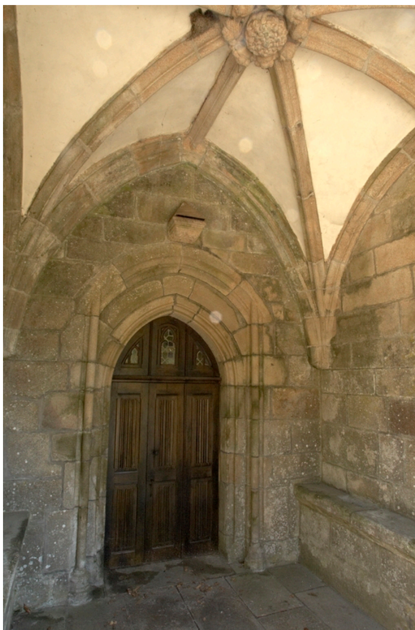
Porche sud, vue oblique de l'intérieur
