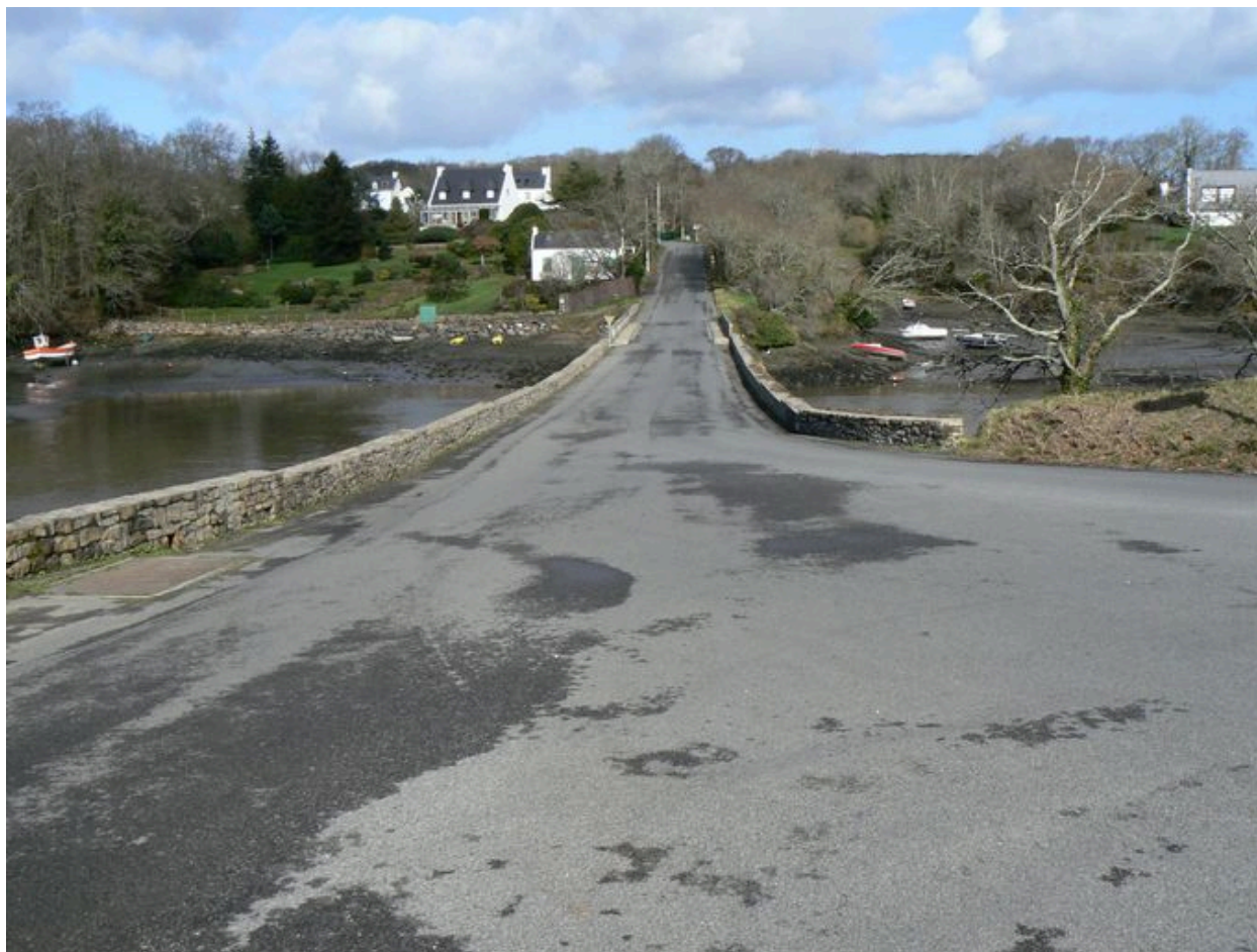
Route passant sur la digue
