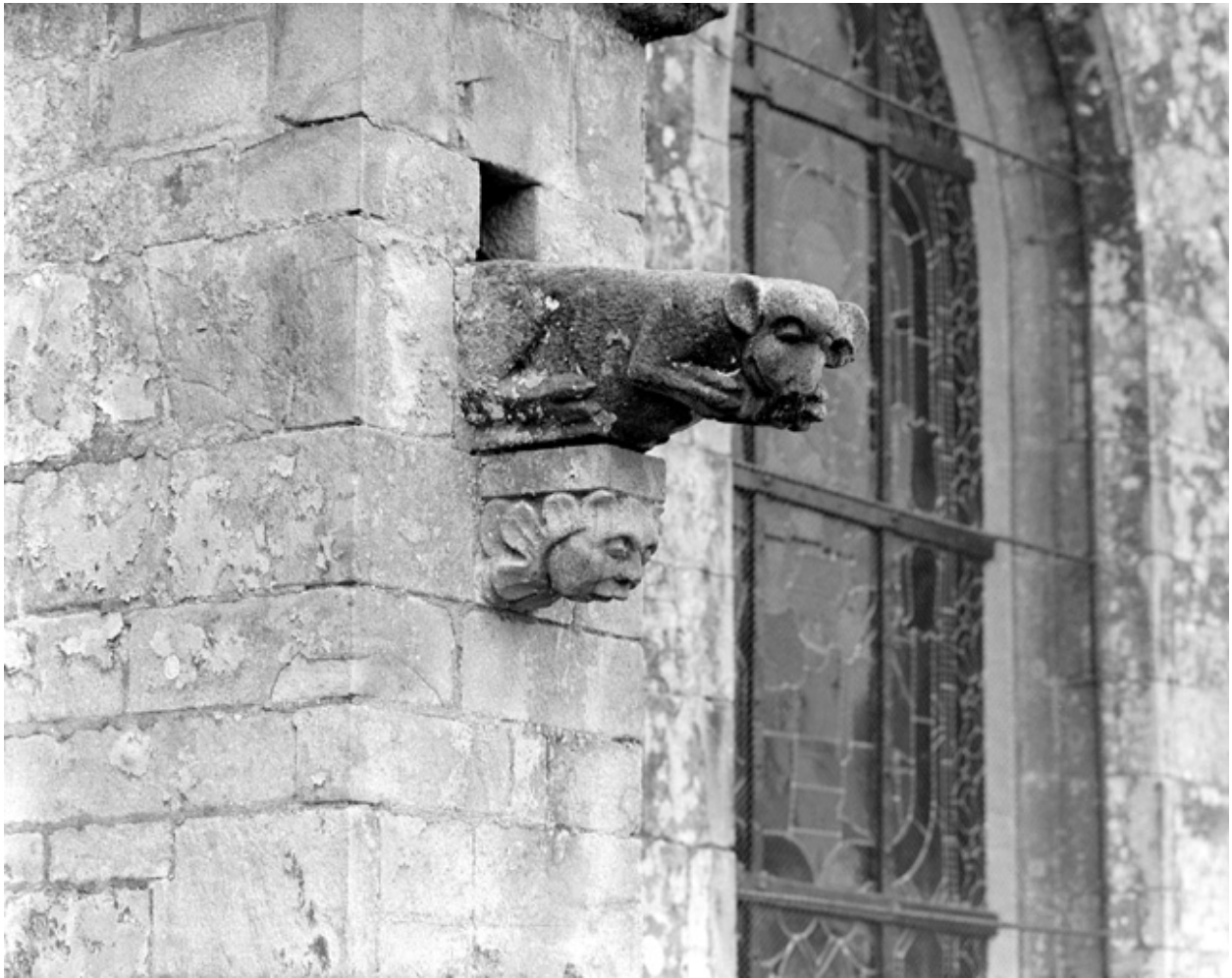
Façade nord, détail, console et gargouille
