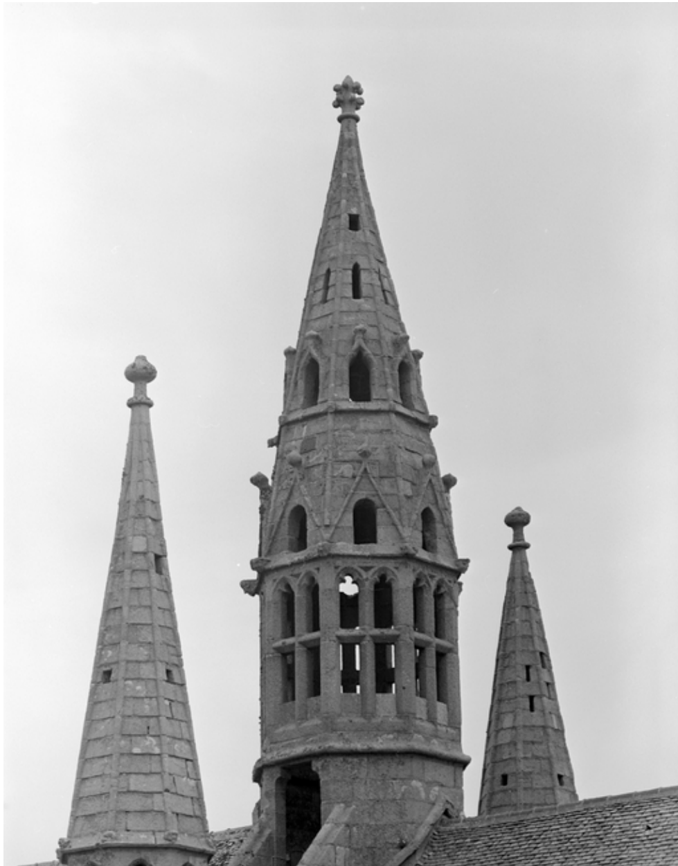
Mur nord, détail clochetons
