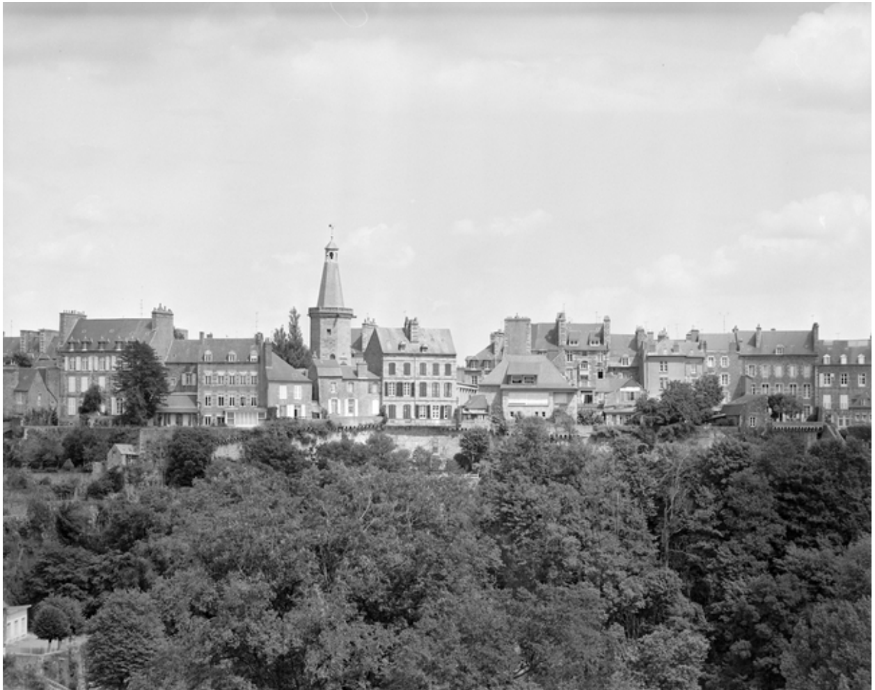
Ville haute intra muros, côté ouest, face ouest des maisons de la rue du Beffroi.
