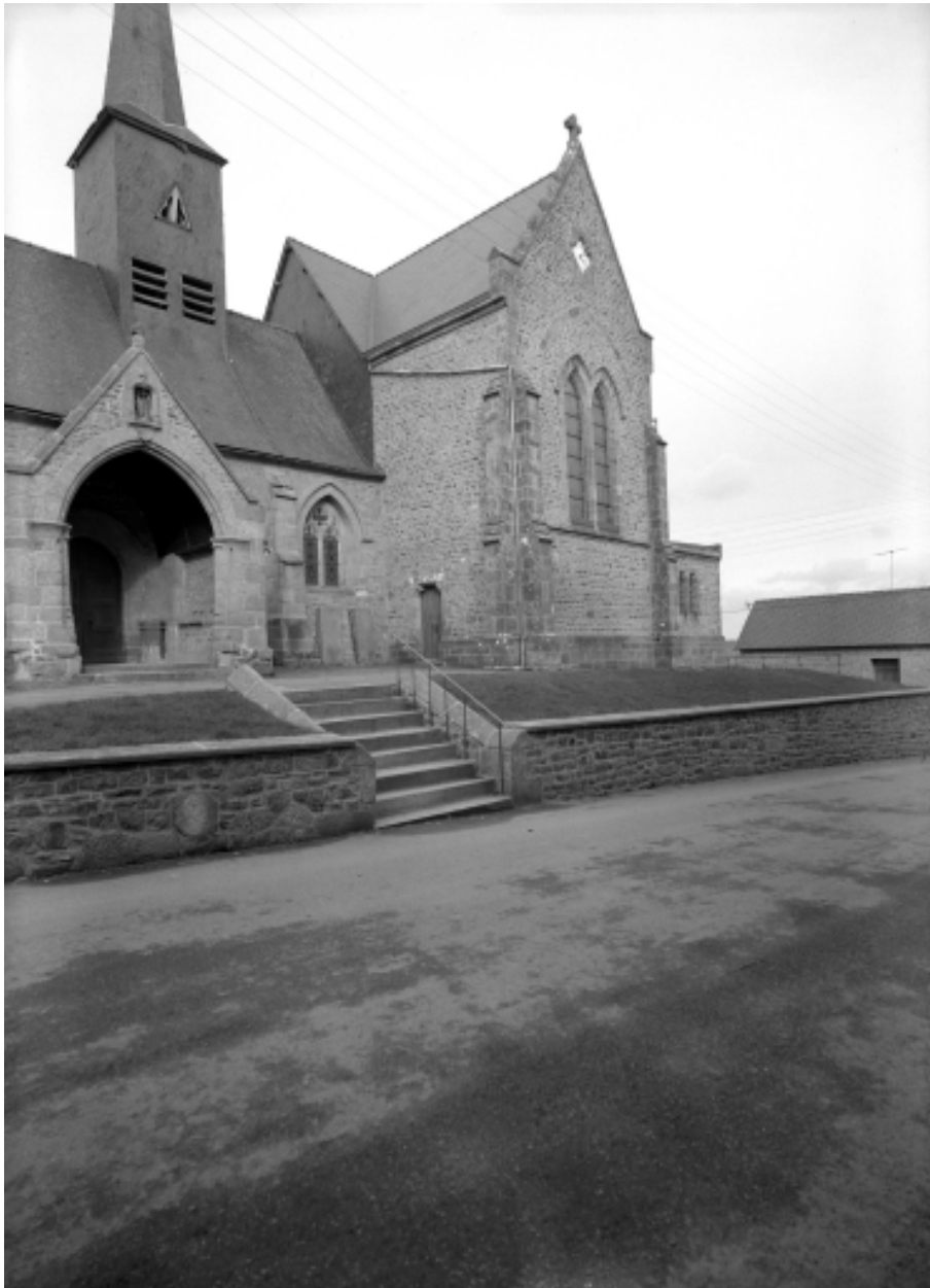
Elévation Sud, partie Est : vue générale
