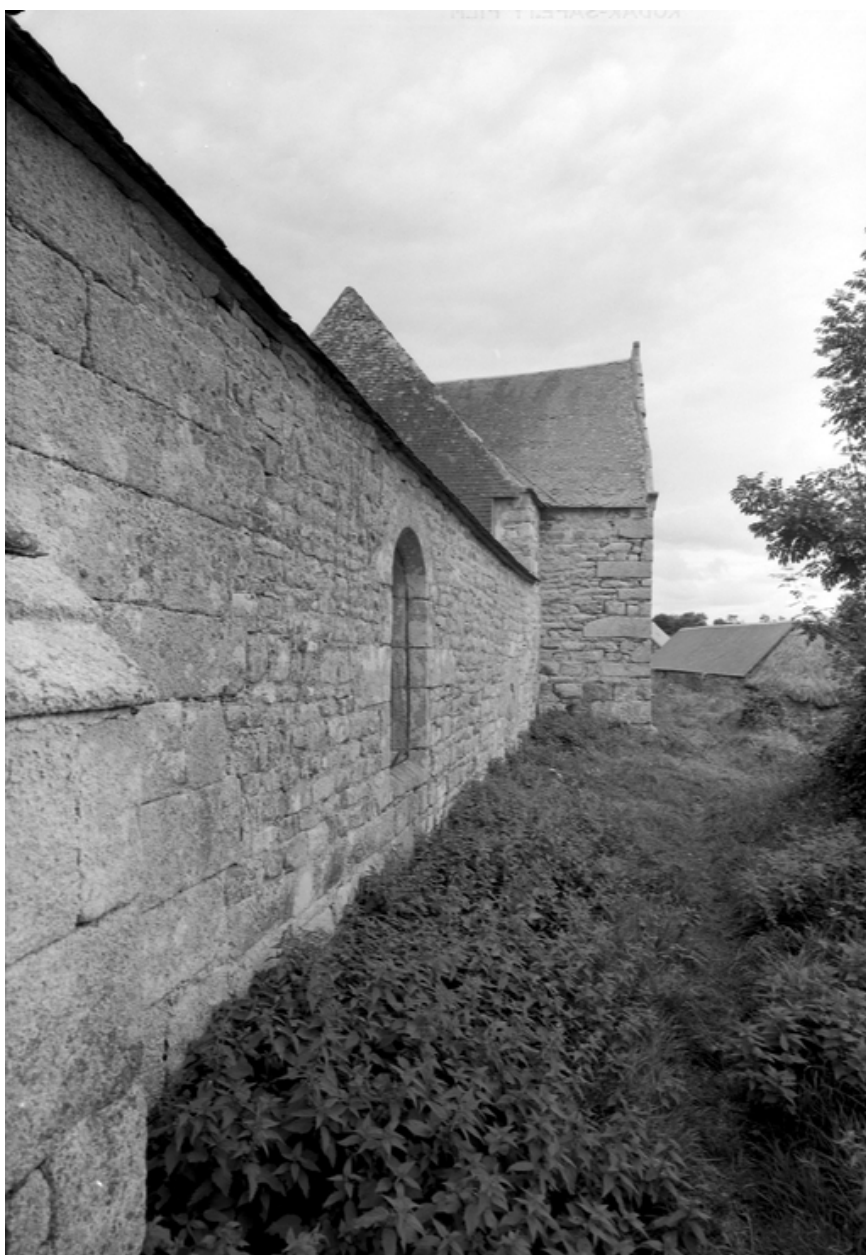
Mur ouest du bras sud
